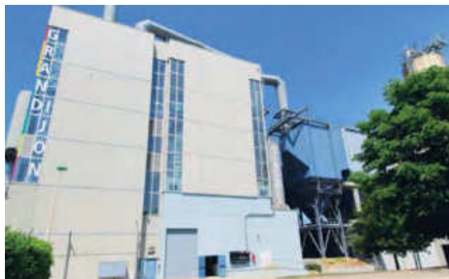
L'usine d'incinération des ordures ménagères du Grand Dijon
