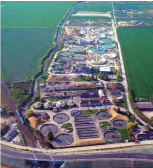
La station d'épuration de Longvic-Dijon
